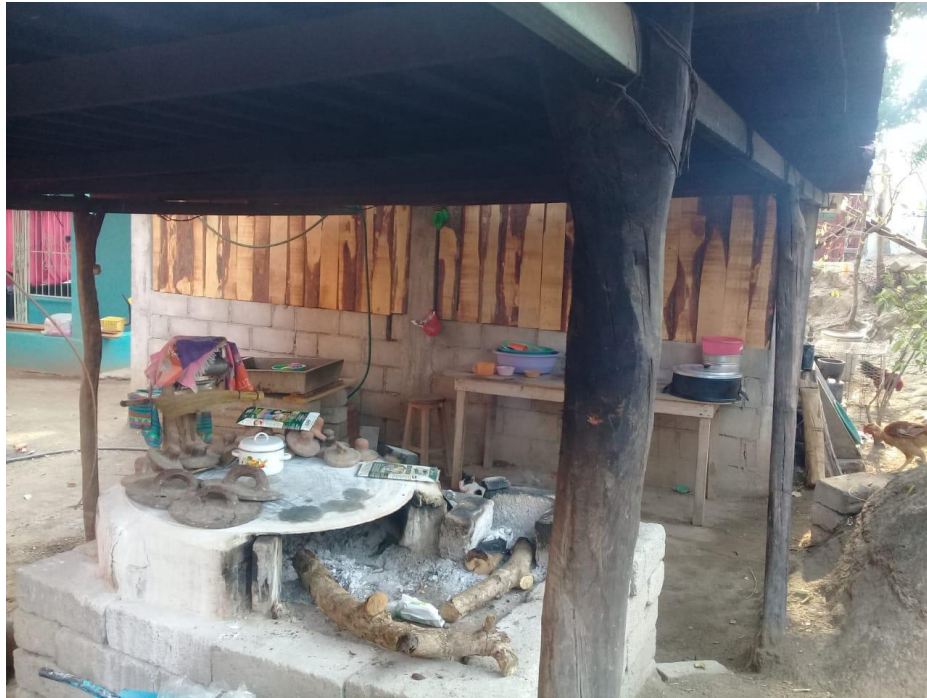
Figura 4. Aspecto de una cocina con el techo impregnado de hollín. Fuente: trabajo de campo.
